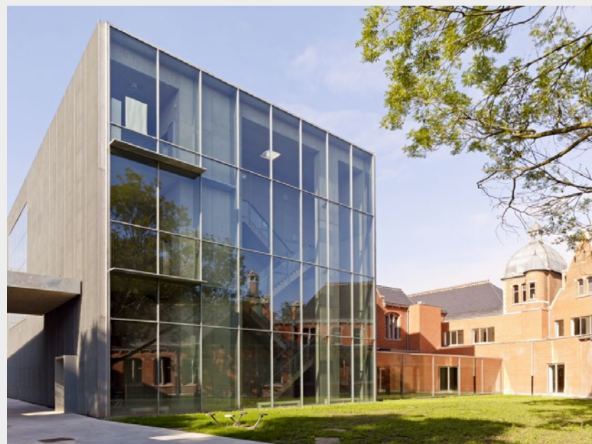
Bijloke, Gent Vliesgevel: forster thermfix vario
